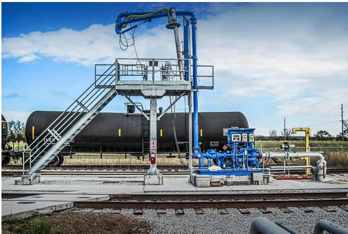
OBRÁZEK 10.6: PLNĚNÍ CISTERNOVÉHO VOZU.
